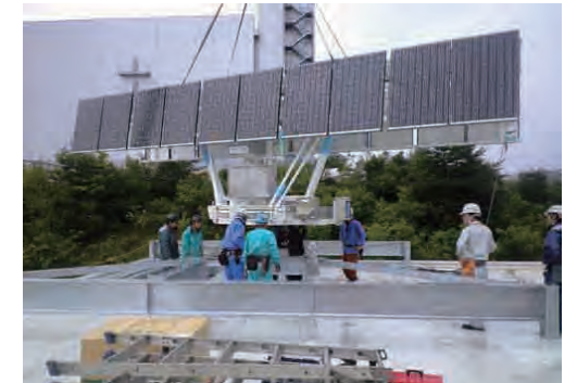
基礎部分に乗せ、本体据付
