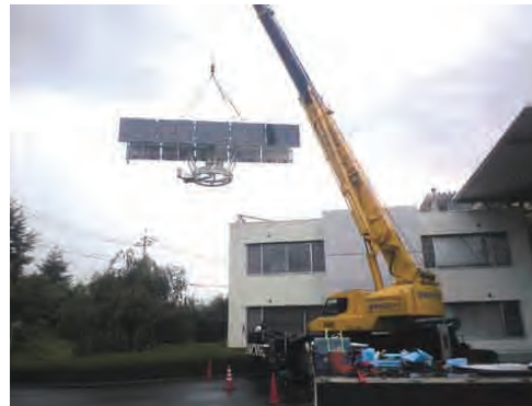
本体を吊り上げ設置
