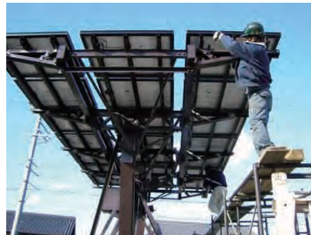
ボルト締め付け・各部チェック
